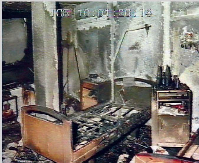
❶ Infolge eines technischen Mangels ausgebranntes Pflegebett
